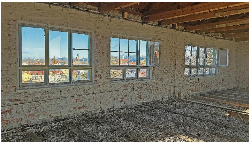
Blick aus dem Gebäude in der Saaburgstraße auf die Altstadt von Landsberg. Auf dem Areal entstehen moderne Wohnungen in attraktiver Lage und mit hoher Wohnqualität. Fotos: Stephan Sieg
